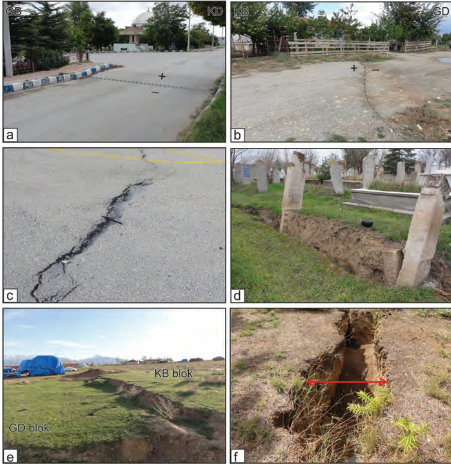
Şekil 8. Bolvadin yerleşim alanı içerisinde gözlenen yüzey deformasyonları. a-b) Akçan parkı ve yakın kuzeyinde yollar üzerinde gözlenen yüzey faylanmaları, c) Bir okulun bahçesindeki asfalt zeminde gözlenen çizgisel gidişli deformasyonlar, d) Bolvadin mezarlığında gözlenen yüzey faylanması, e) Bolvadin Abdülvahab Gazi Türbesi civarında gözlenen yüzey faylanması f) Bolvadin mezarlığı güneybatısında gözlenen yüzey yarığı
